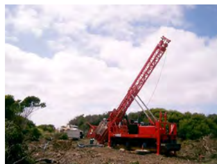
掘削リグによる地盤作業
