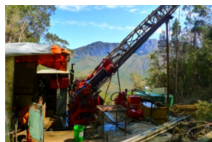
ダーウィン南部における掘削リグの様子
